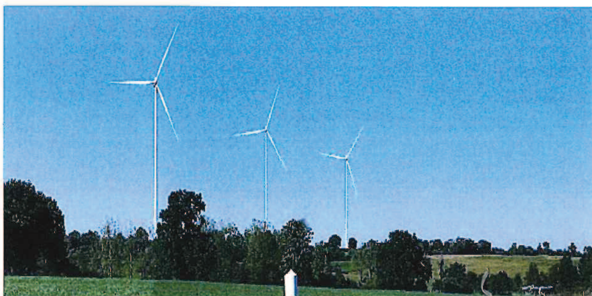
Parc Eolien des Avaloirs
